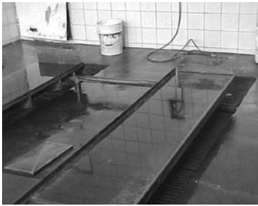
Rejillas desarenadora bajo elevador para vehículo
