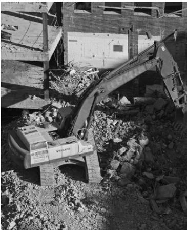
Uno de los primeros pasos para los proyectos de demolición implica una inspección visual que ayuda a identificar la existencia de transformadores, tambores, cámaras de frío, calderas, cañerías, líquidos, tanques y otros elementos que requerirán un manejo o evaluación especial.
